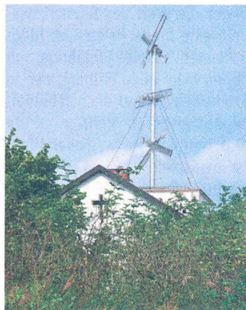
Die optische Telegrafstation Nr. 32 ist weithin sichtbar. Auch der Mast mit den sechs Indikatoren (Signalarme) wurde generalüberholt.
